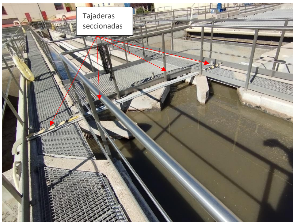
Ilustración 7 - Tajaderas actuales de entrada a decantación primaria. Zona 2.
