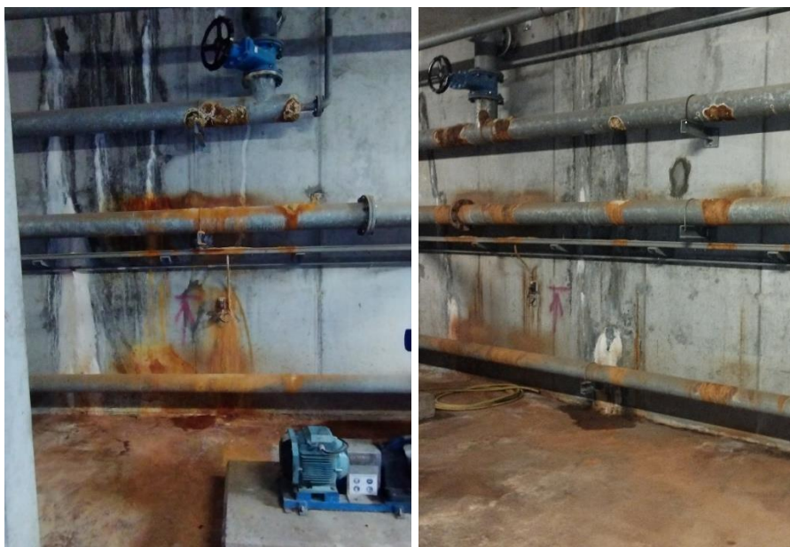
Ilustración 13 - Tuberías en galería corroídas a sustituir.
