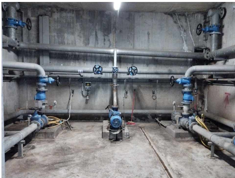
Ilustración 12 – Red de tuberías en galería de la decantación primaria. Vaciado intermedio de los decantadores e impulsión de fango primario a espesador de gravedad.
