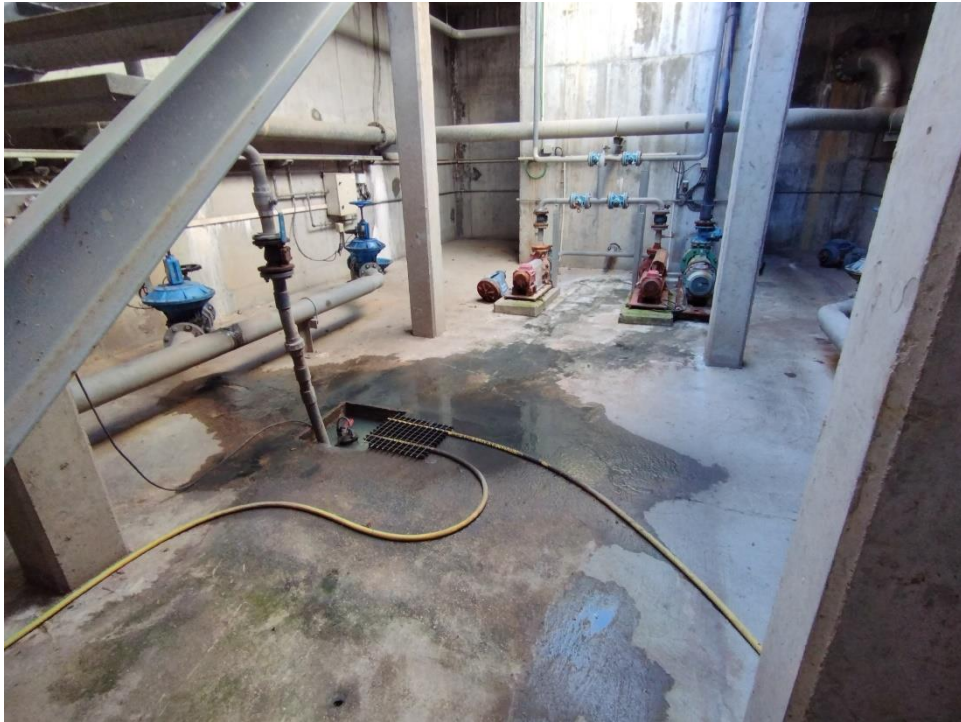
Ilustración 18 – Red de tuberías en galería de la decantación primaria.
