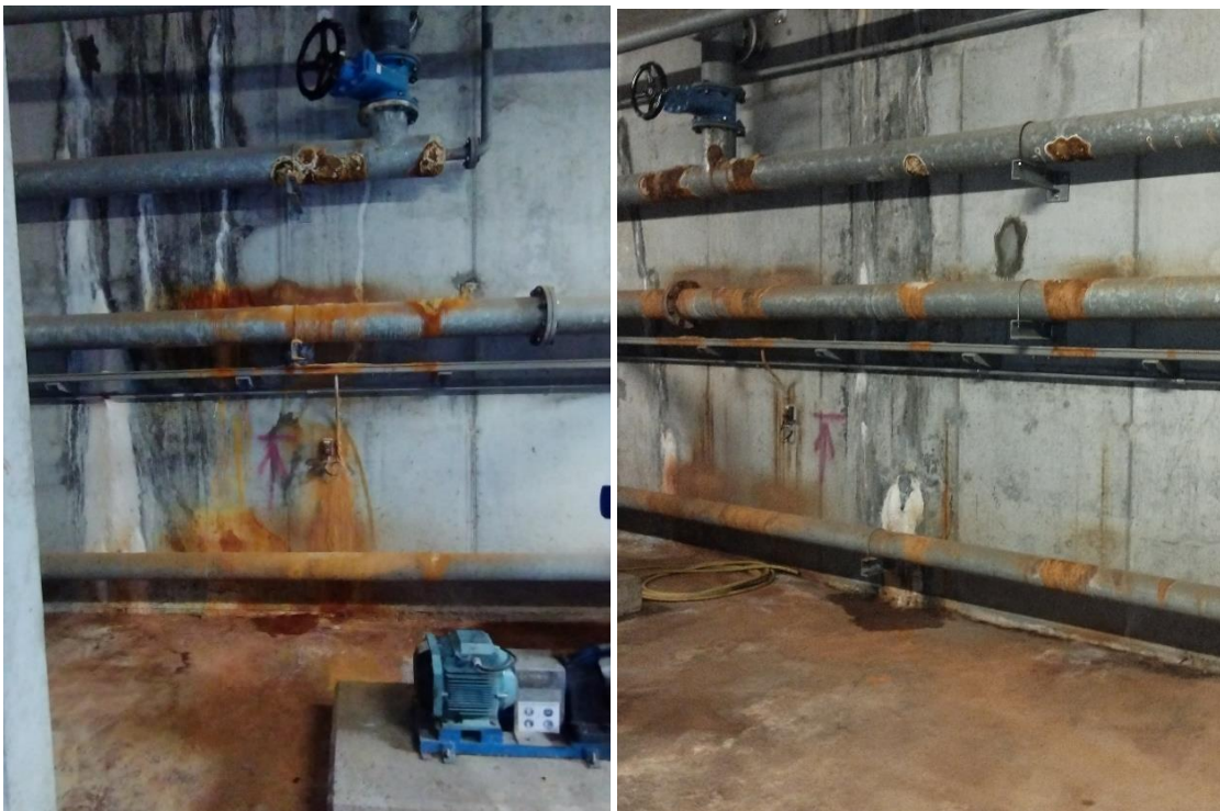
Ilustración 19 - Tuberías en galería en mal estado
