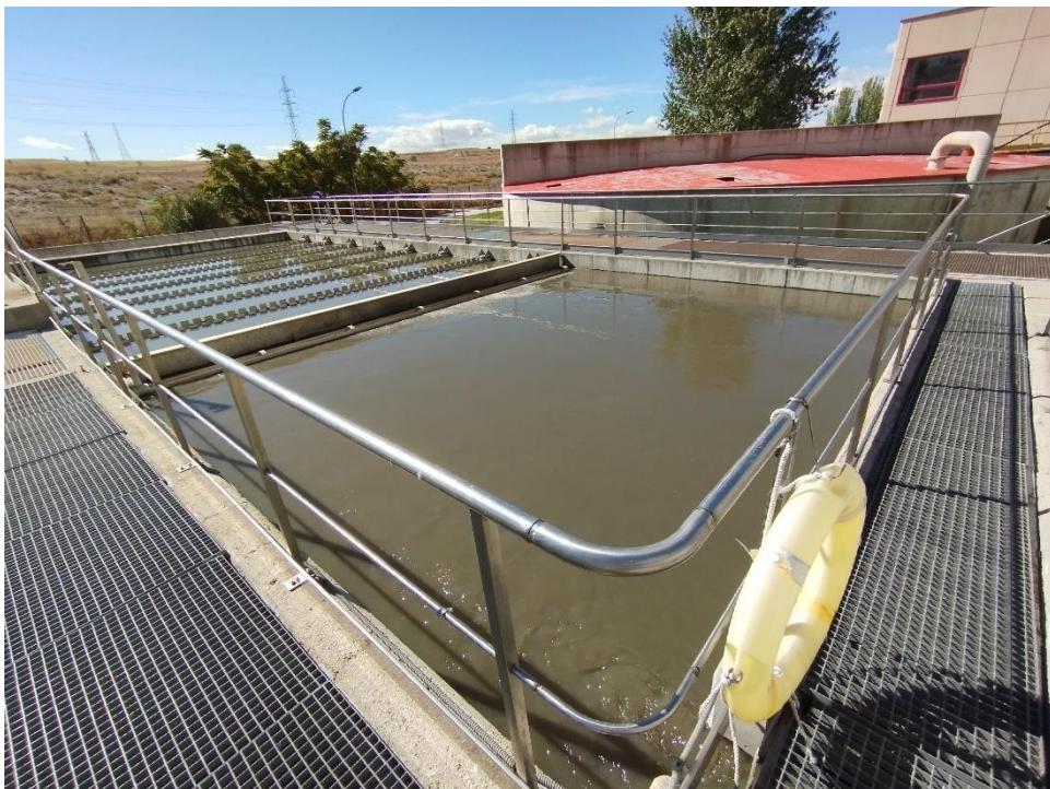
Ilustración 3 - Decantador lamelar en servicio.
