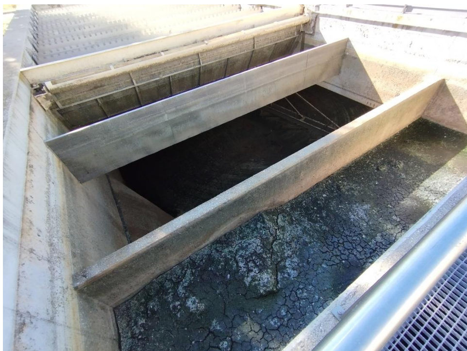
Ilustración 5 – Decantador lamelar fuera de servicio.
