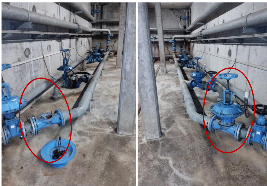
Ilustración 14 - Válvulas de membrana de accionamiento neumático.
