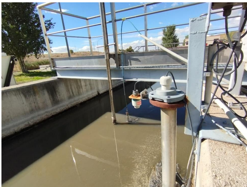
Ilustración 3 - Medición de caudal de agua pretratada.
