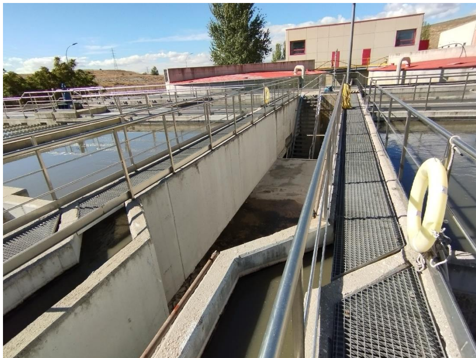
Ilustración 11 - Canales de entrada a decantación primaria. Tramo final.
