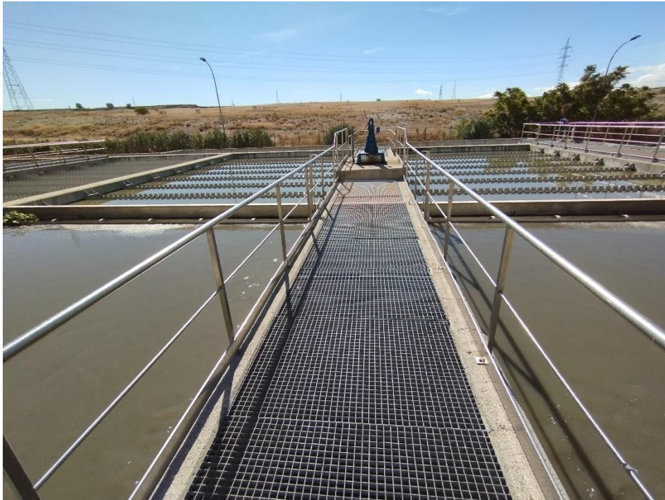
Ilustración 2 - Decantador lamelar en servicio.
