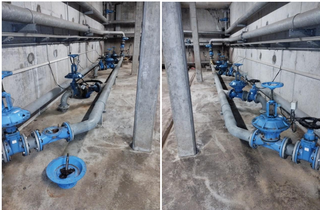
Ilustración 15 - Válvulas de membrana actuales para purga de la decantación primaria.
