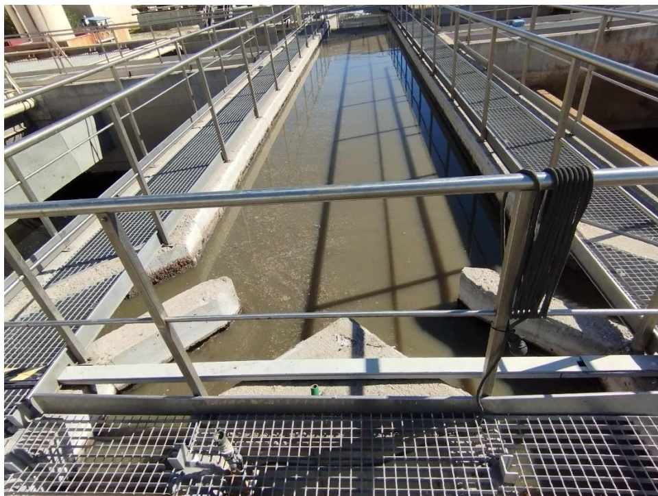
Ilustración 9 - Compuertas actuales de entrada a decantación primaria. Zona intermedia.
