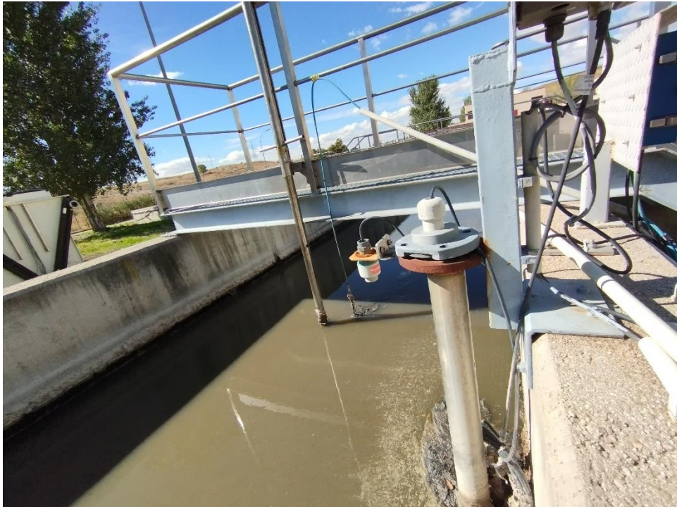
Ilustración 1 - Canal de entrada a decantación primaria. Medición de caudal.
