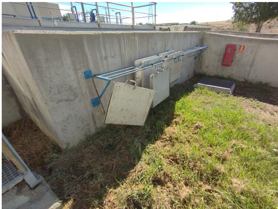
Ilustración 10 – Compuertas de entrada a decantación primaria. Tajaderas seccionadas.
