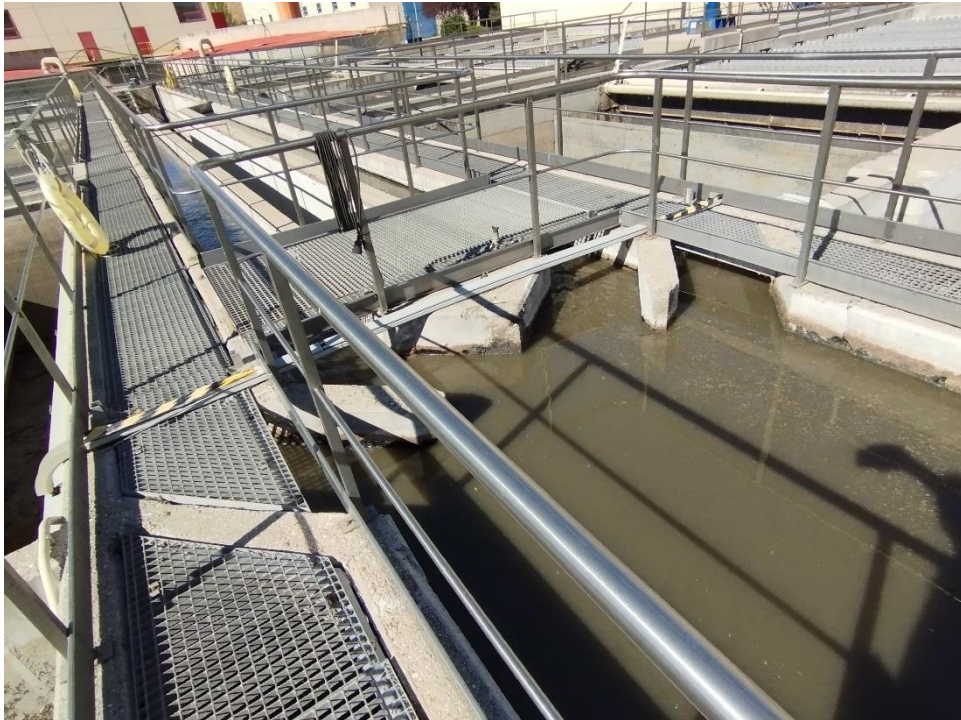
Ilustración 8 - Compuertas actuales de entrada a decantación primaria. Zona intermedia.
