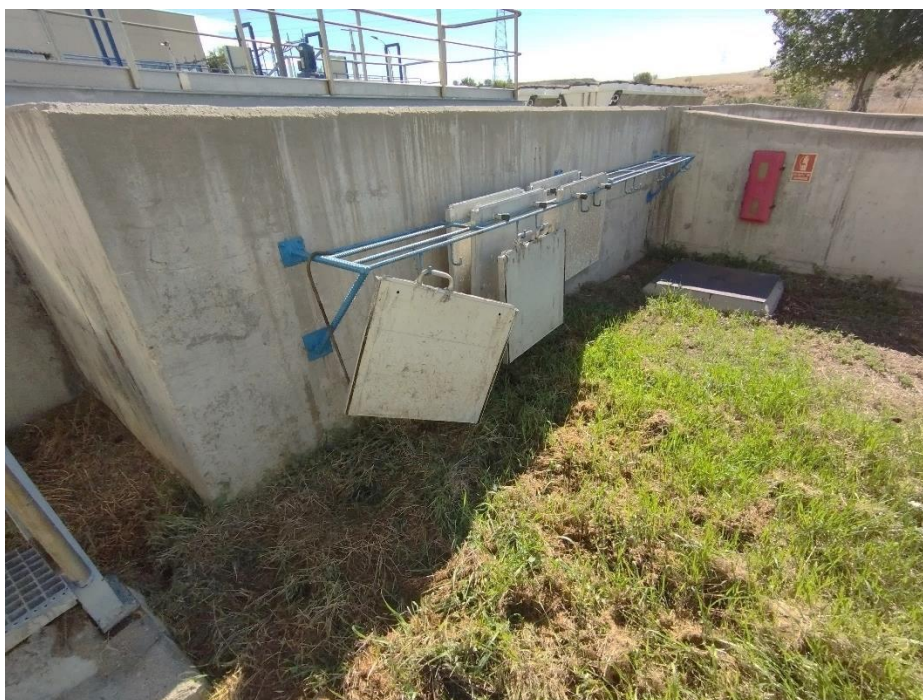
Ilustración 4 – Tajaderas de entrada a decantación primaria.
