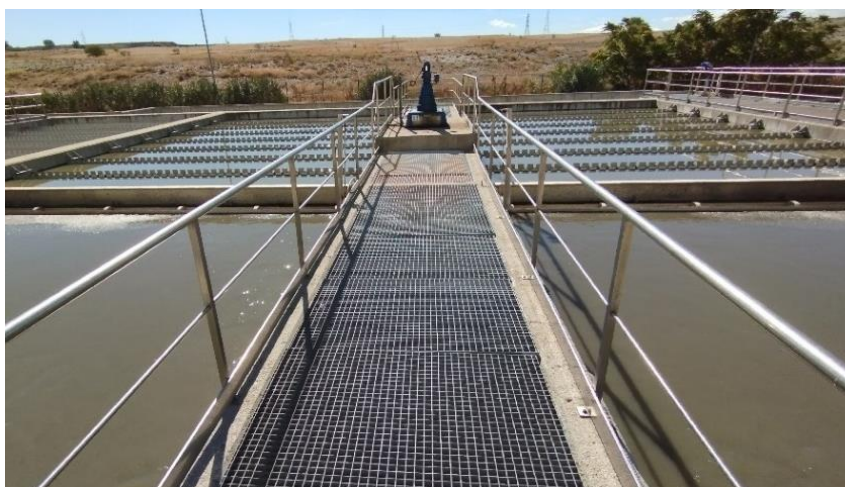
Ilustración 15 - Pasarela intermedia decantador primario.
