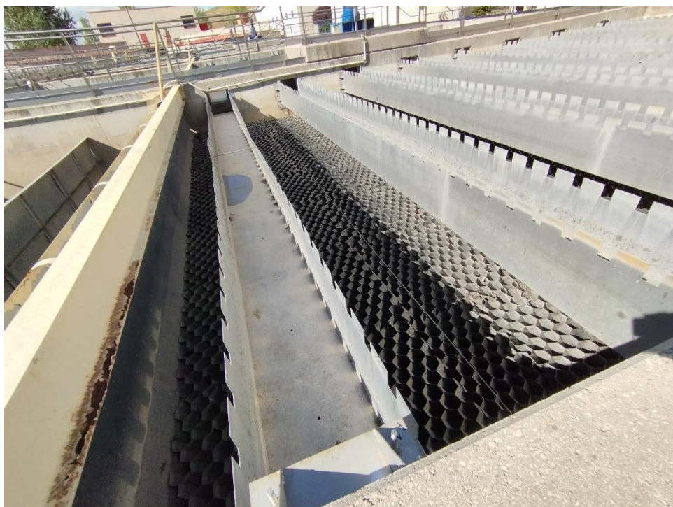
Ilustración 6 – Lamelas en decantador lamelar vacío.
