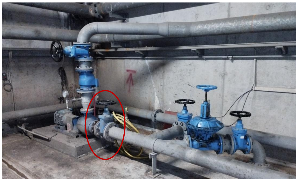
Ilustración 11 - Válvula de compuerta manual de bomba de fango primario.
