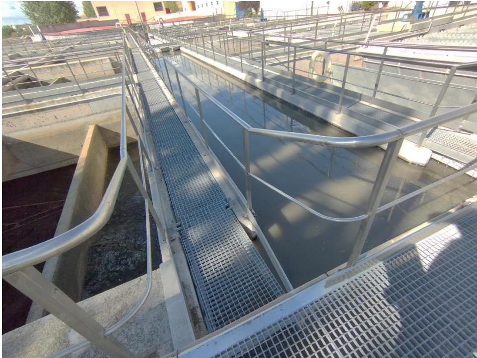
Ilustración 7 – Compuertas actuales de entrada a decantación primaria. Zona inicial.
