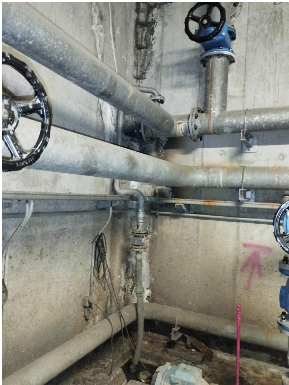
Ilustración 13 – Red de tuberías en galería de la decantación primaria. Pasamuros red de vaciado intermedio.
