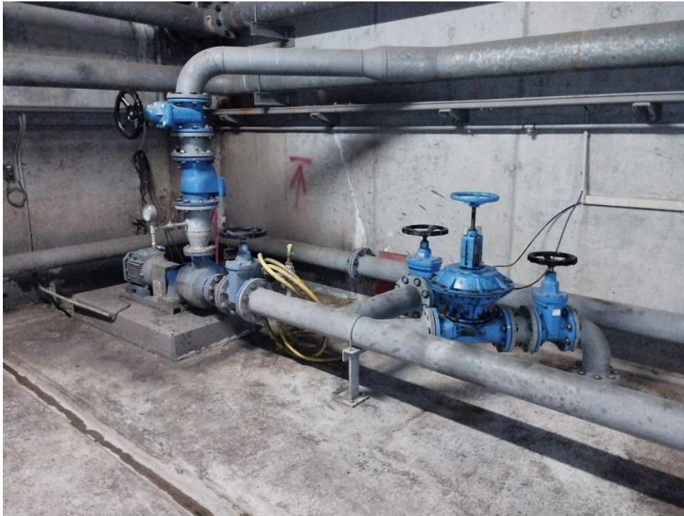
Ilustración 14 - Impulsión de fango primario a espesador de gravedad.
